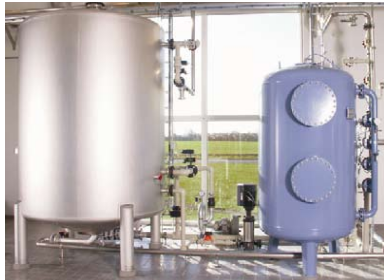
Desorpcja rozpuszczonych gazów, takich jak agresywny dwutlenek węgla, metan i siarkowodór, jako proces poprzedzający filtrację. Zdjęcie: desorber i filtracja ciśnieniowa w browarach.
